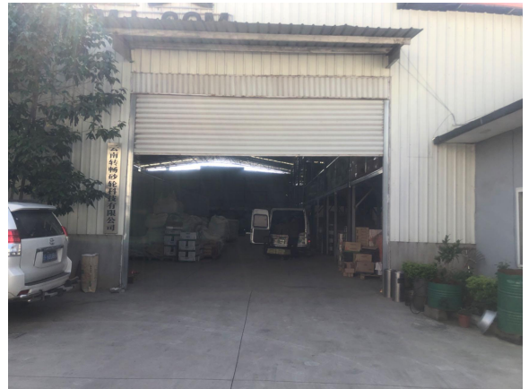
项目南面云南转畅砂轮科技有限公司
