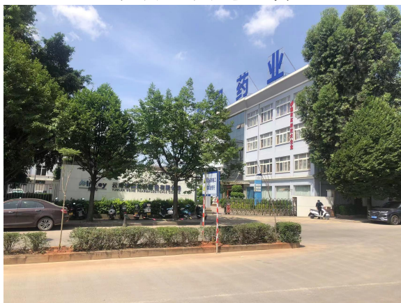
项目西北面维和制药
