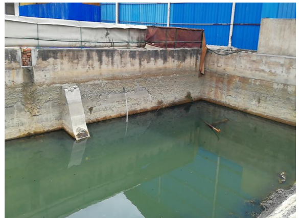
项目依托 200m 3 初期雨水收集池
