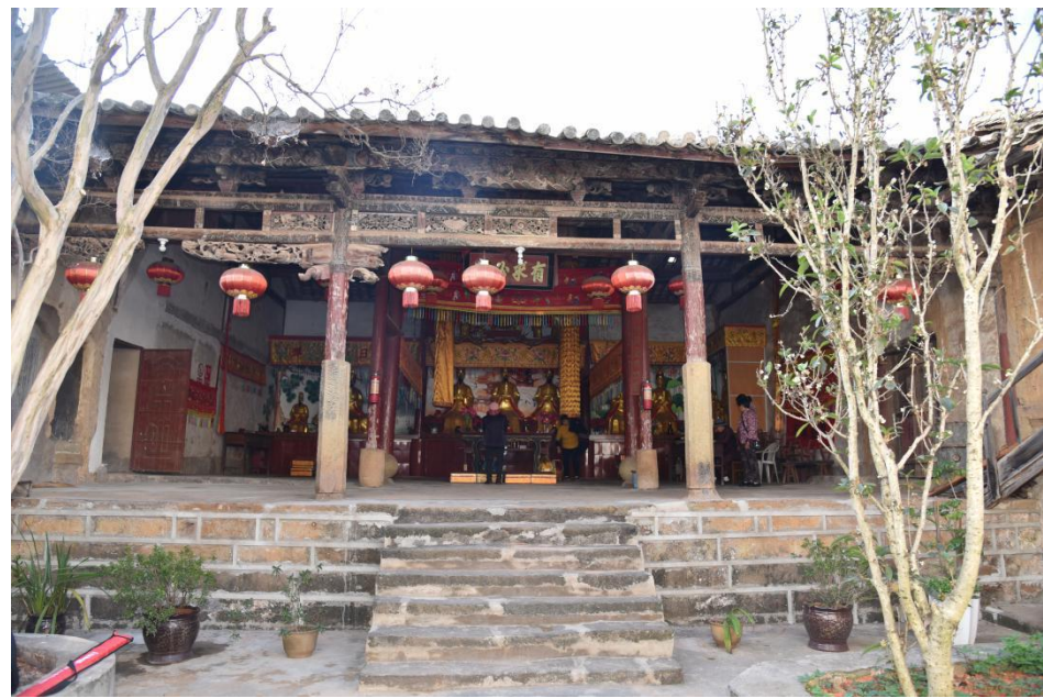
编号 01 大殿正立面 拍摄部位 正立面 拍摄日期 2019. 11. 26
