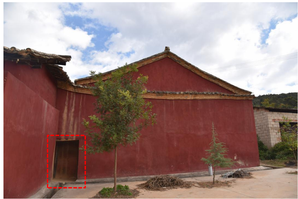
编号 04 后期制安铁门扇 拍摄部位 东侧立面 拍摄日期 2019. 11. 26
